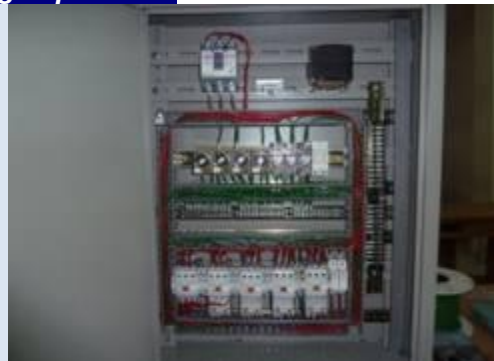
Thiết bị mô phỏng hệ thống điện trên máy mài
