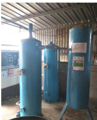
Hình 4. Sơ đồ hệ thống lọc biogas sử dụng cho máy phát điện
